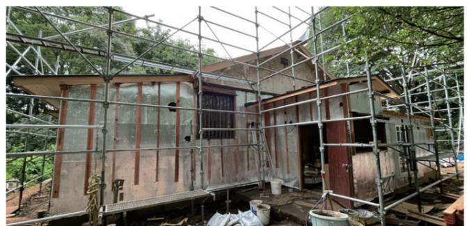
屋根は、既存の引っ掛け桧の上に新しい垂木と野地板を形成し、その部分に断熱材・遮熱材を施工
